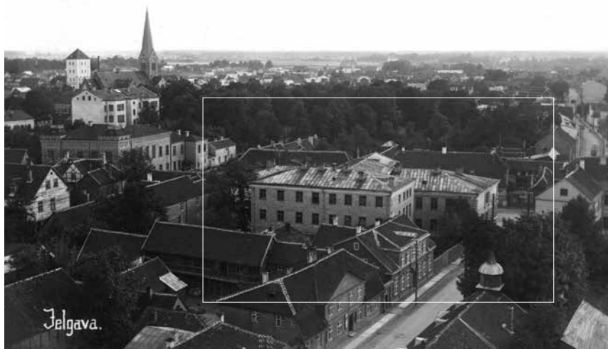
Skats uz Jelgavas Valsts ģimnāzijas ēku Pasta ielā no katoļu baznīcas torņa. No JVMM.
