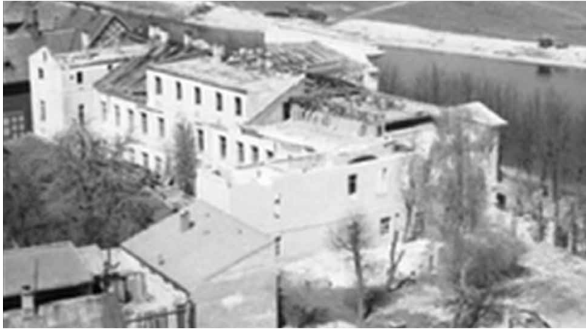
1939.gads. Sākušies skolas ēkas nojaukšanas darbi Upes ielā 13. No JVGA.
